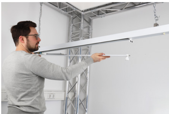
1 - alte Leuchteneinsätze raus [Verkabelung bleibt drin]
