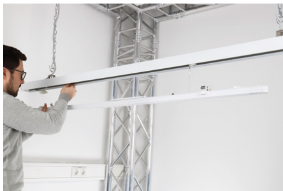
2 - neue LED Module in alte Tragschiene einhängen
