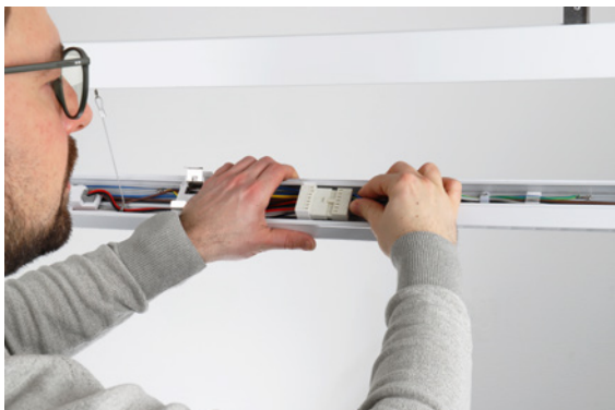
3 - Module Verbinden und ggf. Leistung einstellen
